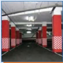
**Protector ignífugo de alta resistencia y durabilidad adaptable a esquinas en ángulo recto, chaflán, columnas circulares, paredes, fondos de plazas en garajes, industrias...**
